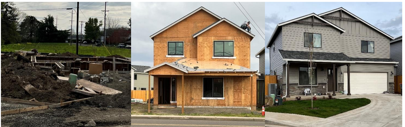
Filbert Pointe Subdivision Construction
